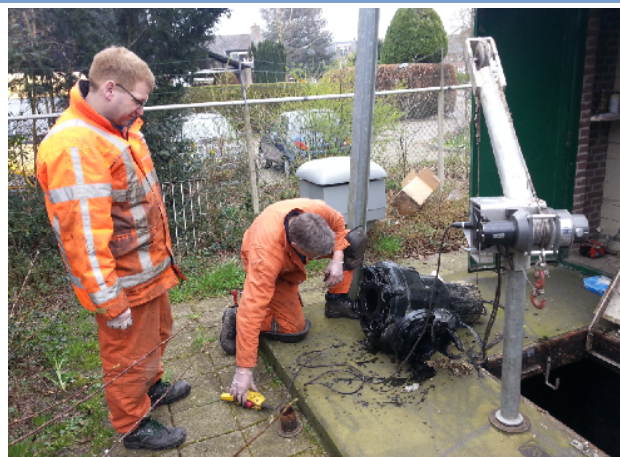
Figuur 25: Onderhoud rioolgemaal Leusden-Zuid
