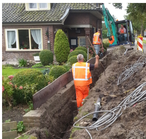
Figuur 13: aanleg drukriolering Arnhemse weg
