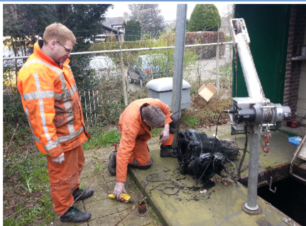
Figuur 25: Onderhoud rioolgemaal Leusden-Zuid
